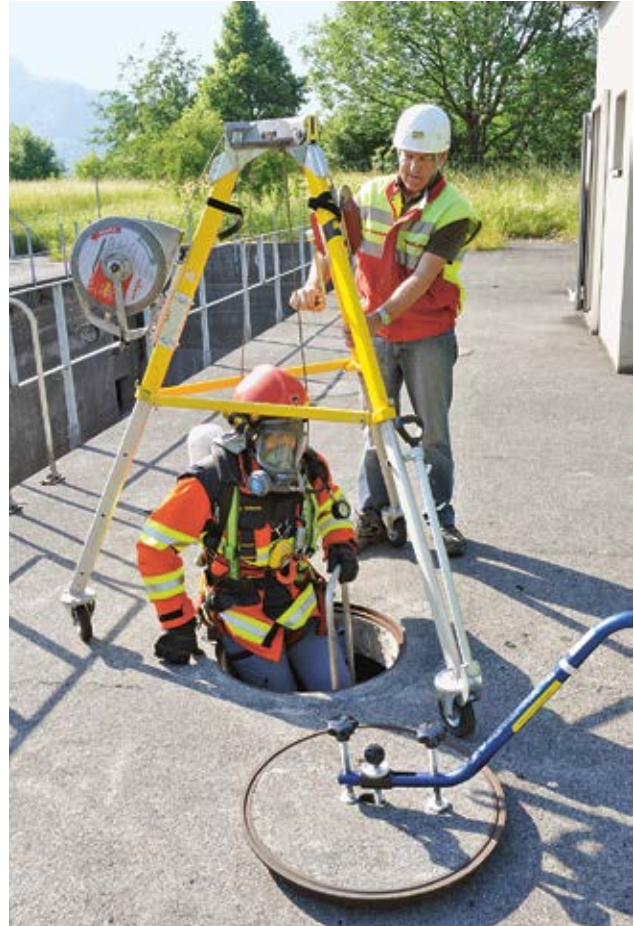
Le travailleur qui descend dans un puits est placé sous la surveillance directe d'un tiers.
